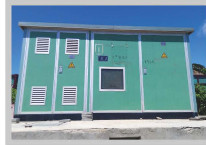
珠海华融大厦变压器
