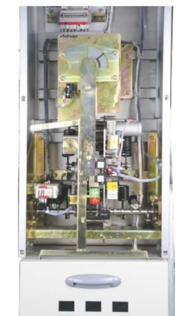
断路器 (V) 单元操作机构
