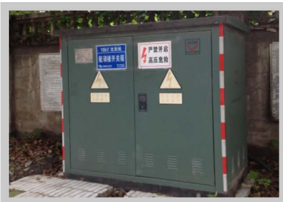
贵州都匀市南方电网公司大楼
