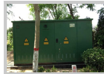
山东省曲阜市供电公司
