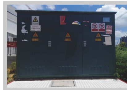
珠海前山商贸物流中心10kV户外开关箱
