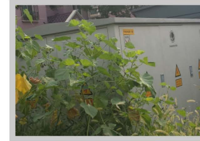
北京地铁6号线
