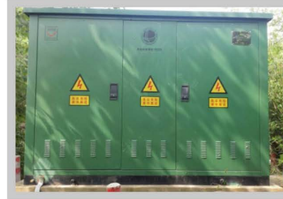
安徽淮南大通变电所环网柜
