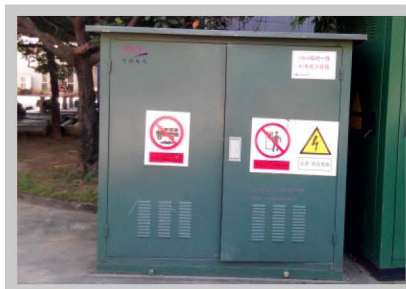
珠海10kV临时一线#1电缆分接箱
